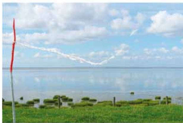
FRIESLAND (NL) Dijk Waddenzee, Westhoek, 11,5 meter
